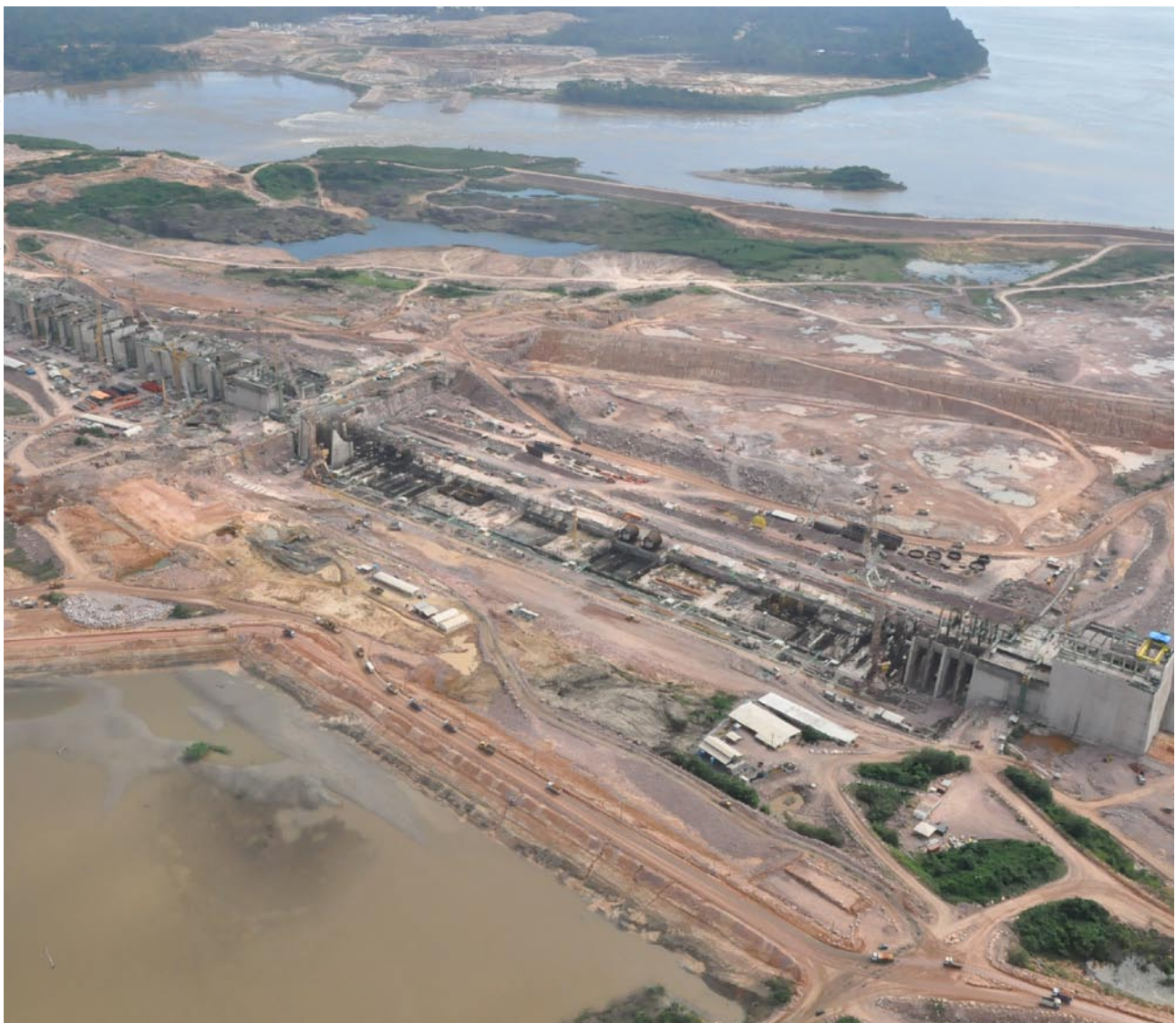
Die Baustelle des Jirau-Staudamms
