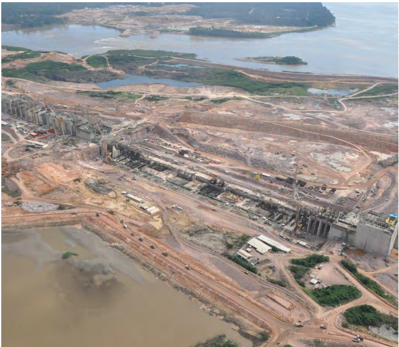
Die Baustelle des Jirau-Staudamms
